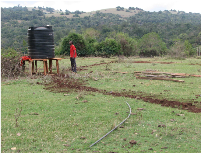
Aanleg van een waterleiding
